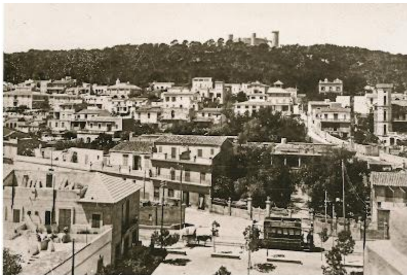
Anys posteriors el tramvia ja s'havia electrificat. La línia Palma – Porto Pi fou la primera el 1916.
